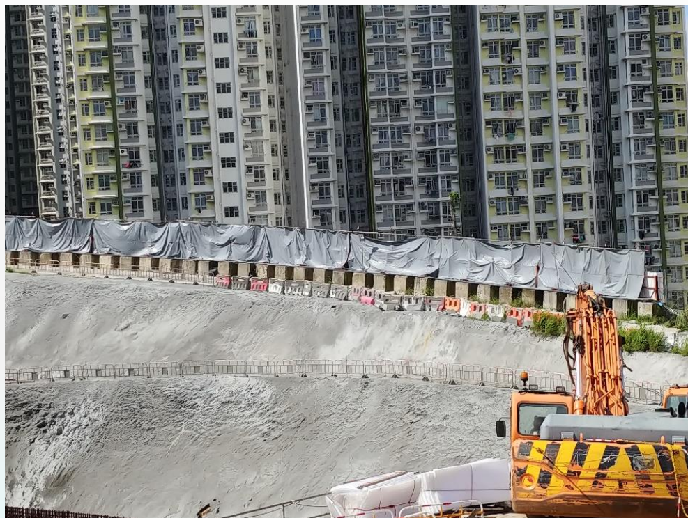
建造隔音屏，防止工程噪音影響民居
