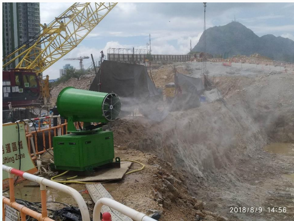
在工地放置霧炮
