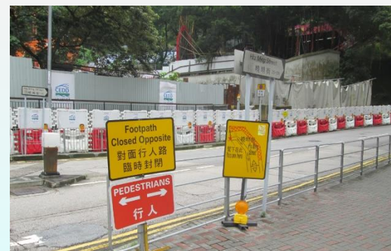
秀茂坪紀念公園行人 扶手電梯地基
