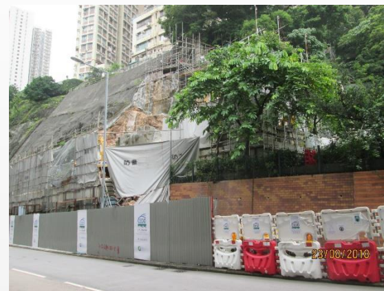
曉明街升降機塔
