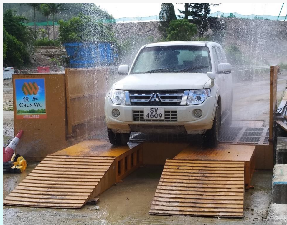
在工地出入口設置車輪清洗設施
