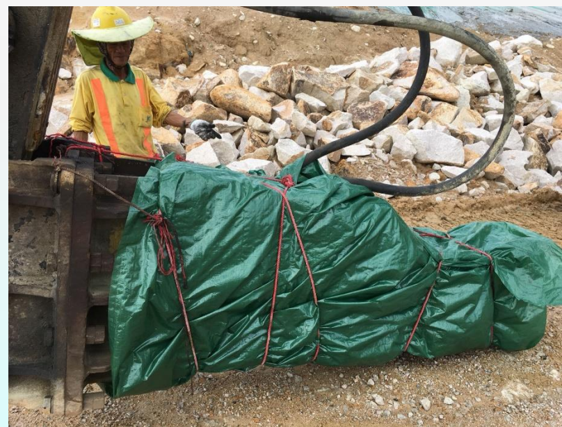
採用隔音布料覆蓋機械設備
