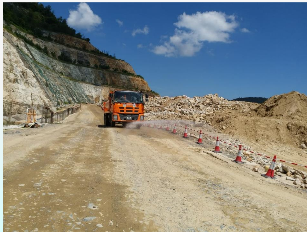
安排灑水車在工地定時灑水
